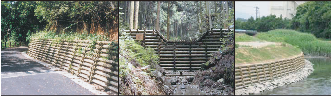
鳥取県 旧城山国有林自然休養林内管理車道土留工
