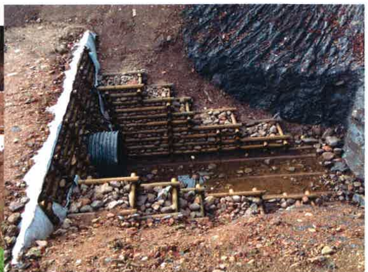
↑ NO3呑口部土留・側壁・水叩工
