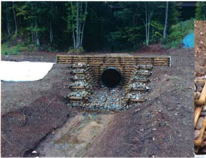
← NA01吐口部土留・側壁・水叩 ↓
