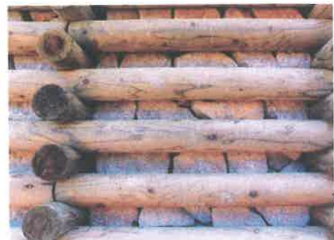
(写真2) 正面から見た中詰礫の状況
