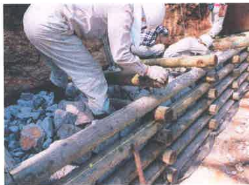
(写真1) 礫の詰込中。粒径の大きいものを壁体の前面に配置する。
