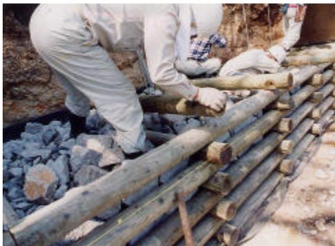
礫の詰込中。粒径の大きいものを壁体の前面に配置する。
