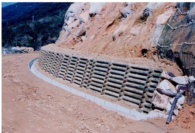
（写真 9）現地発生石積による安定措置の一例
