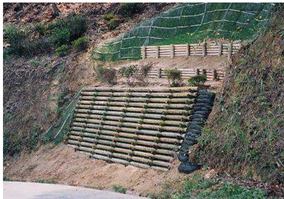
(写真 11) 右端の余堀部に種子付土のう積工を、 左端に人工張芝工を施工した例
