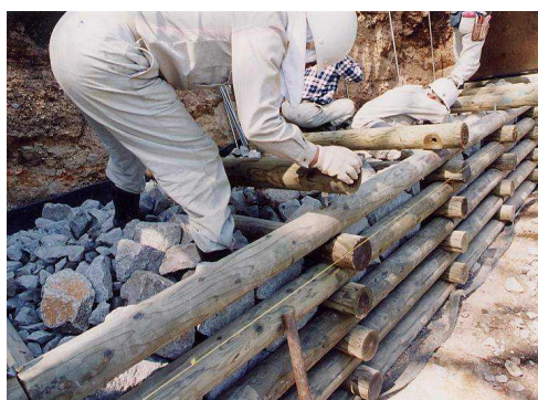
(写真7) 礫の詰込中。粒径の大きいものを壁体の前面に配置する。
