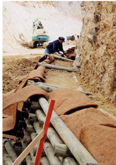
(写真6) 締固後の中詰・背面 埋戻し状況
