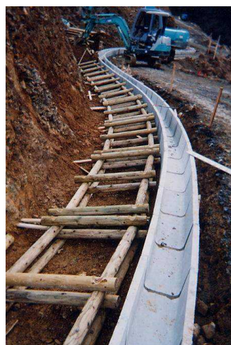
(写真 3) 曲線部における 2 段目の組立中（控材が 2 本の箇所が縦断の変化点）
