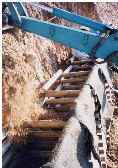
(写真5) 中詰及び埋戻し 施工状況
