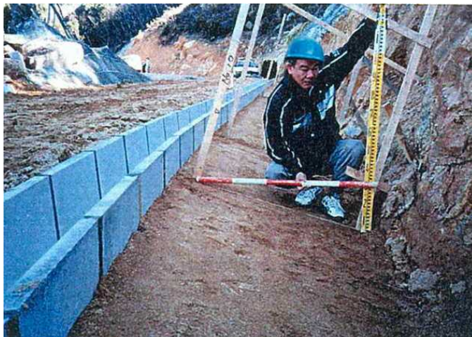
（写真1） 1:0.30 の所定勾配で整正された床堀完了状況。
