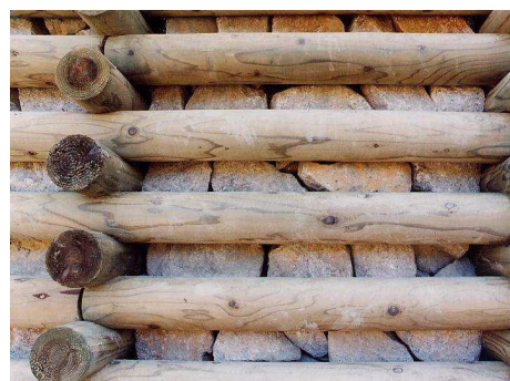
(写真8) 正面から見た中詰礫の状況
